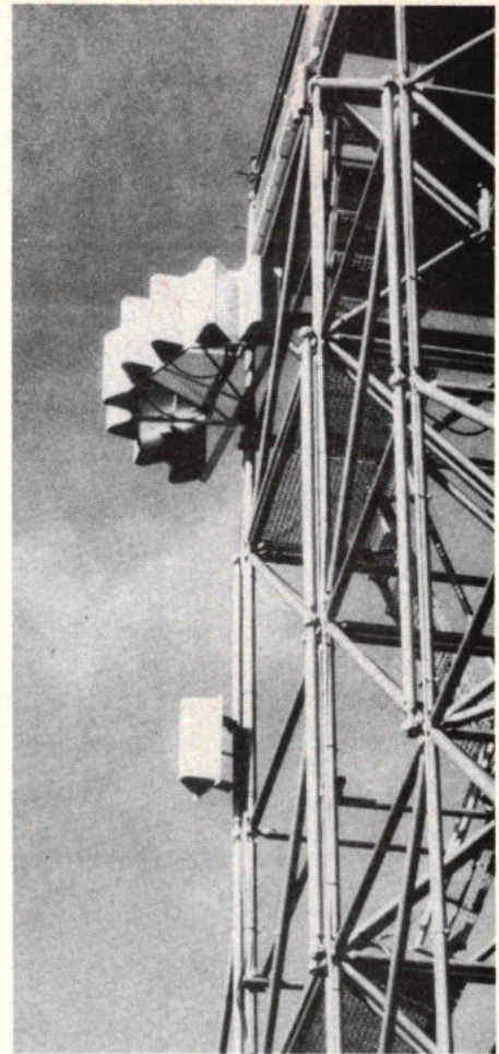
Afb. 2. Peilstations bepalen automatisch de plaats van de om hulp roependen.
